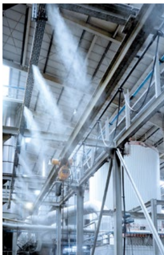
Condair ML Flex Hochdruckdüsen bei Argelith Bodenkeramik H. Bitter GmbH in Bad Essen
