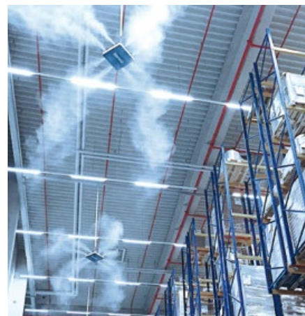
Hochdruck-Luftbefeuchter DRAABE TurboFogNeo 8 im Hochregallager
