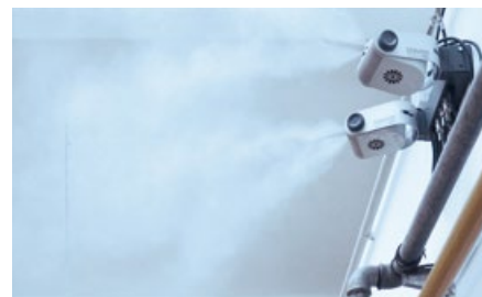
Luftbefeuchter sichern eine störungsfreie Produktion
