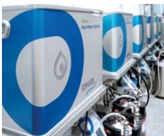
Mehrstufige Wasseraufbereitung der Hochdruck-Luftbefeuchtung
