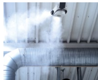
Die Vernebler vom Typ TurboFog versprühen bei Bedarf einen mikrofeinen Nebel
