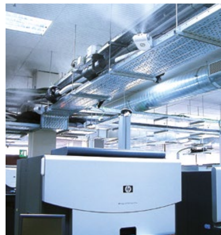
Optimale Luftfeuchte schützt vor Elektrostatik im Digitaldruck
