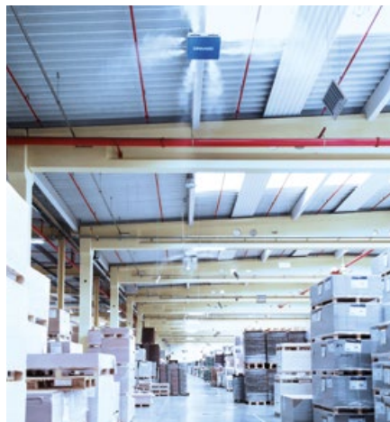
Hochdruck-Luftbefeuchter DRAABE TurboFogNeo 8 im Papierlager
