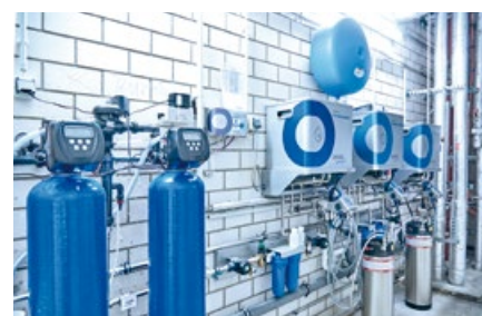
Die mehrstufige Wasseraufbereitung garantiert eine sichere und keimfreie Luftbefeuchtung
