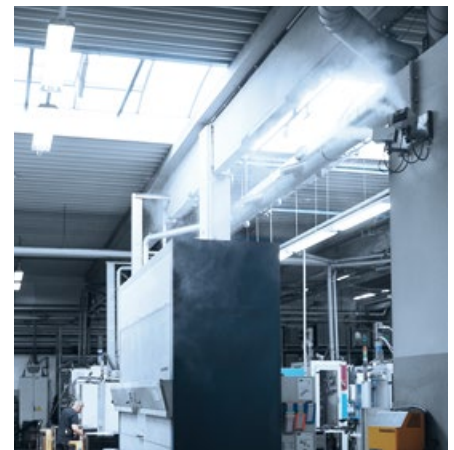
Hochdruck-Luftbefeuchter DRAABE TurboFog im Produktionsbereich
