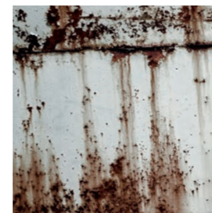
Schutz vor Rost und Korrosion
